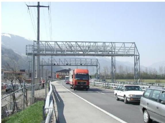
Bei zur Zeit 23 fixen Kontrollanlagen auf dem schweizerischen Autobahnnetz werden die Daten des Erfassungsgerätes über die DSRC-Funkverbindung ausgelesen und mit den von der Anlage elektronisch gemessenen Daten (Kontrollschild, Fahrzeuglänge, etc.) automatisch verglichen. Ausländische resp. Fahrzeuge ohne Erfassungsgerät werden über das Kontrollschild erkannt. Ein auf dem restlichen Strassennetz eingesetztes Fahrzeug kann standortunabhängig eingesetzt werden.
