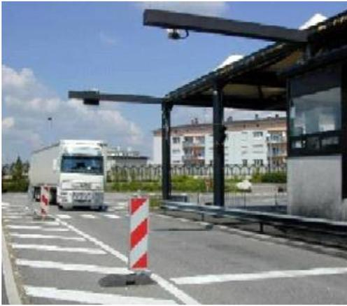
Beim Grenzübertritt wird die Kilometeraufzeichnung automatisch ein- oder ausgeschaltet. Dies geschieht über eine kurzreichweitige Mikrowellen-Funkverbindung. An den Grenzübergängen sind dafür Funkbaken über den Fahrbahnen installiert. Diese Funktechnologie ist unter dem Kürzel DSRC (Dedicated Short-Range Communication) bekannt und für die elektronische Gebührenerfassung europaweit standardisiert.
